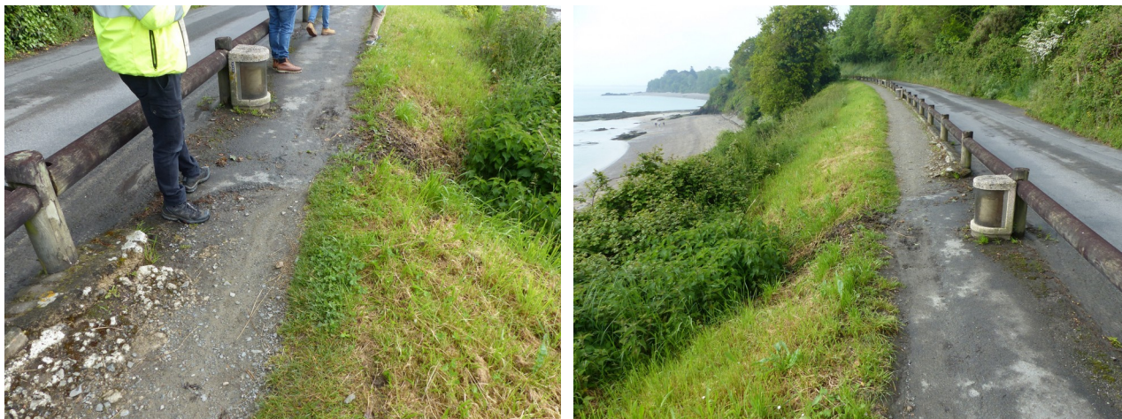
Érosion sur l'accotement et en sommet de talus à l'extrémité de la bordure de canalisation des eaux de ruissellement
