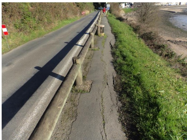
Fissuration du GR34 en février 2016 entre P.525 et P.535 (source Rateau Ing.)
