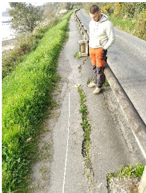
Fissuration du GR34 en avril 2021 entre P.573 et P.579 (source Rateau Ing.)
