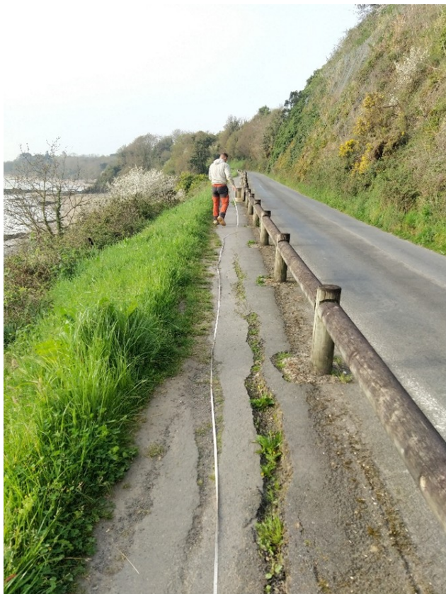
Fissuration du GR34 en avril 2021 entre P.510 et P.535 (source Rateau Ing.)
