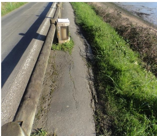
Fissuration du GR34 en février 2016 vers P.515 (source Rateau Ing.)
