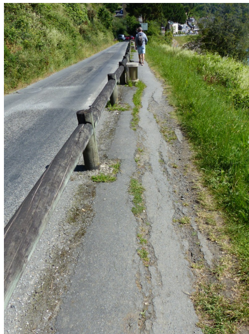
Evolution de la fissuration du GR34 en juin 2024 entre P.525 et P.535 (Cerema)
